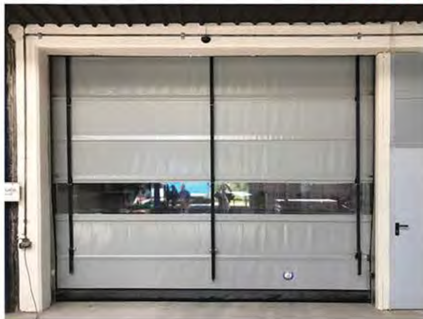
Siguran i bezbedan rad foto ćelija i sigurnosna kontakt guma kao dodatni element bezbednosti
